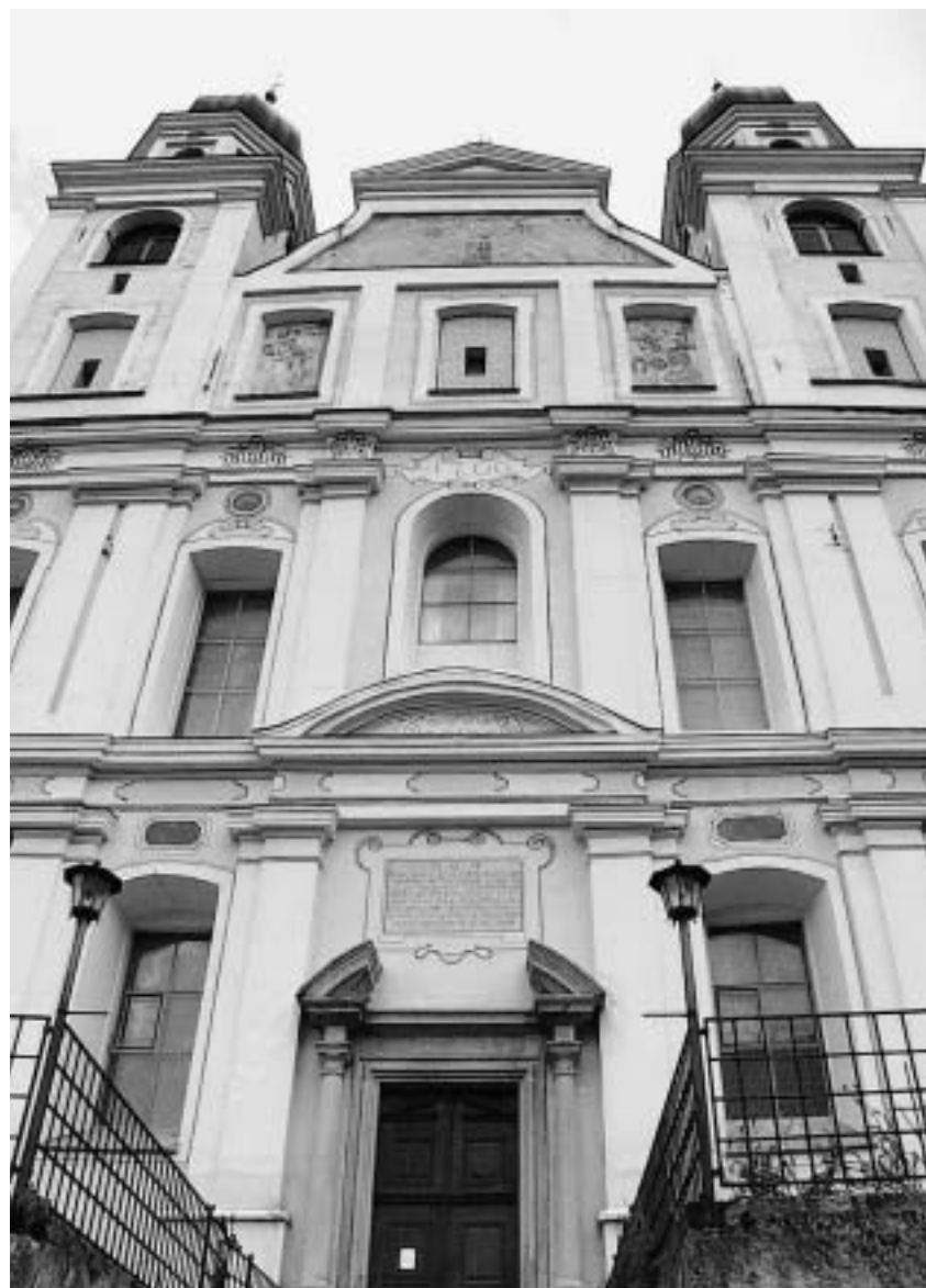
Der schöne Schein trägt: Die Fassade der Klosterkirche in Disentis bedarf ebenso wie die Innenräume dringend der Renovation. Bild Jano Felice Pajarola
