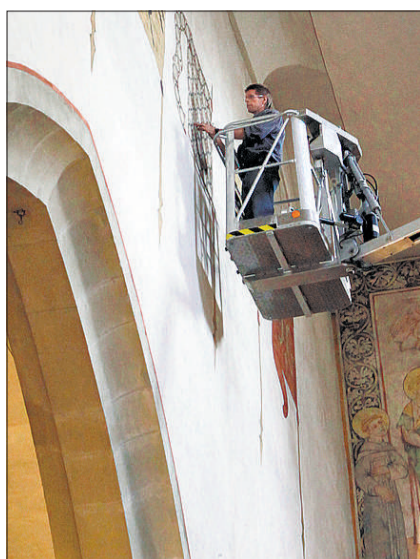
Zum Putzen der Franziskanerkirche braucht es Hebebühnen. BILD MISCHA CHRISTEN
